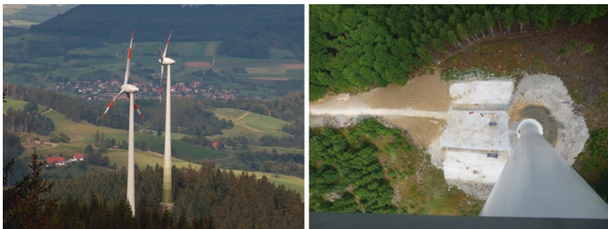
Abb. 2.1 WEA werden in Deutschland zunehmend an Waldstandorten errichtet. (© Horst Schauer-Weisshahn)
