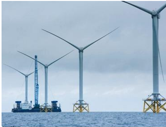
Ormond Offshore Wind Farm UK (31 structures) Image via Vattenfall
